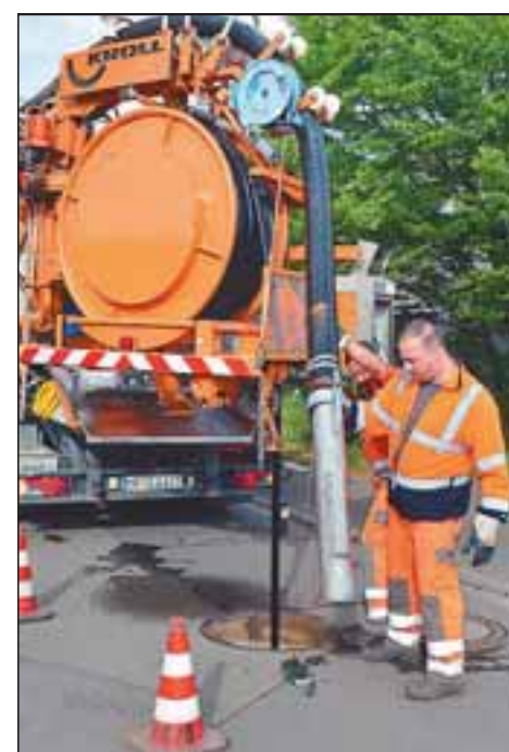
Beim Einstieg in Kanäle wird Sicherheit großgeschrieben (oben). Die Reinigungsfahrzeuge des Abwasserzweckverbandes sind mit Hochdruckdüsen ausgerüstet (rechts). In der Altstadt sind historische Kanalfragmente aus früheren Zeiten zu sehen (unten).
