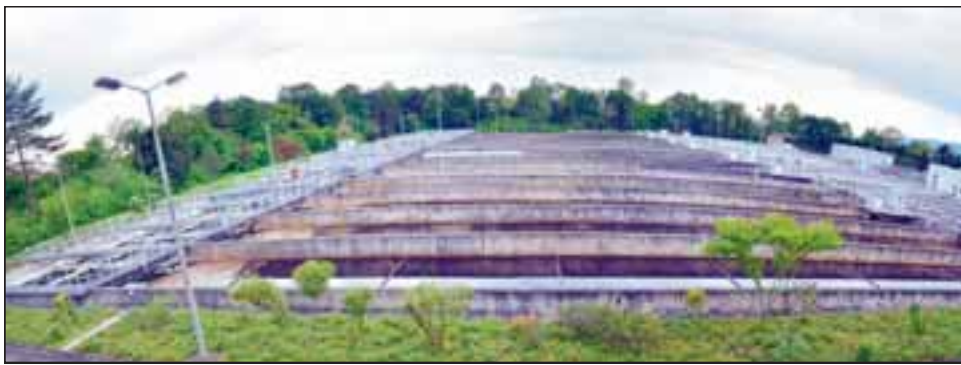
Die Beckenanlage im Klärwerk Nord, das auf Handschuhsheimer Gemarkung steht.
